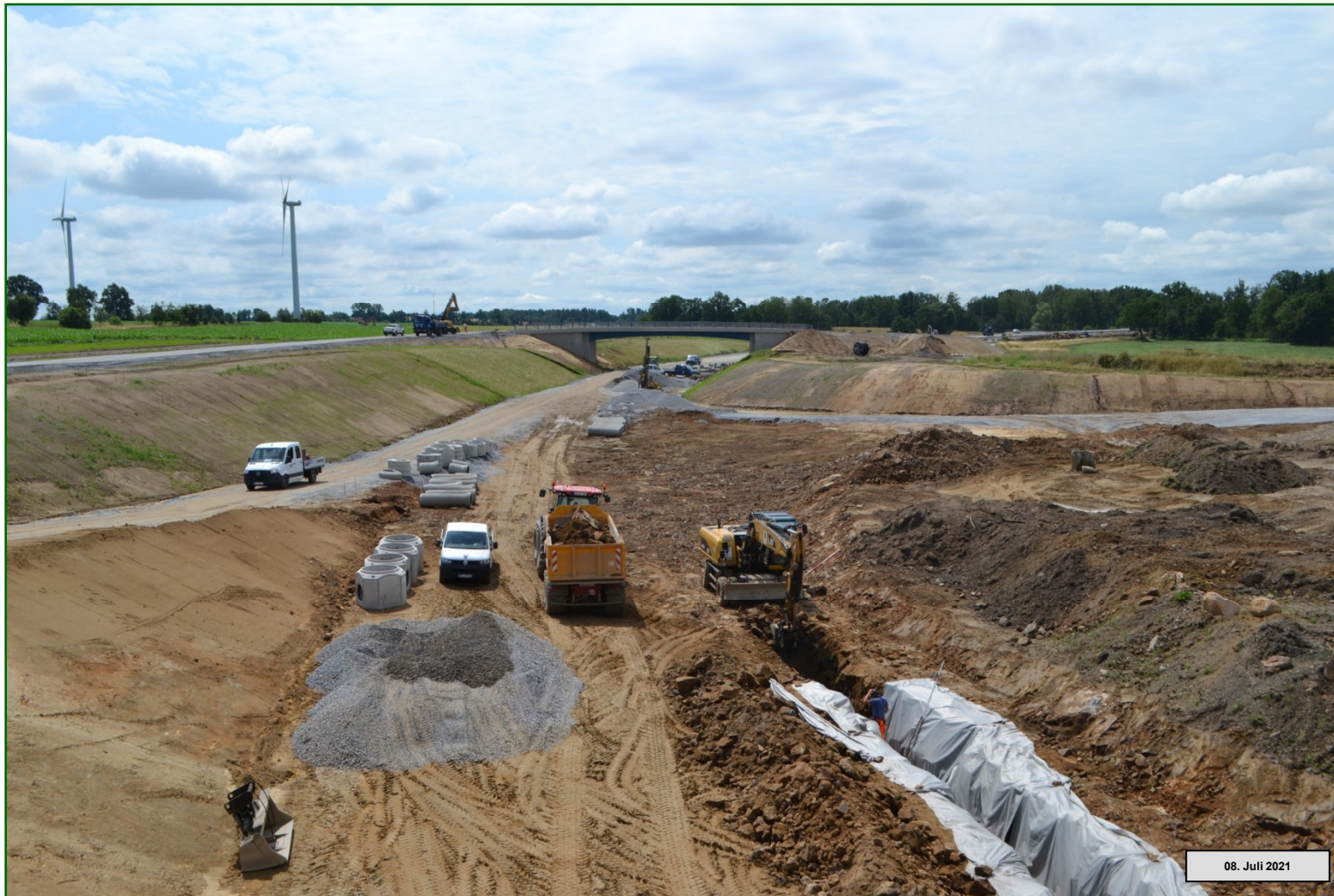
Staatsstraße S 177 - Radeberg bis Bundesautobahn A 4 Erdbau im Straßenbaulos 5.1 südlich von Leppersdorf ( Anschlussstelle )
