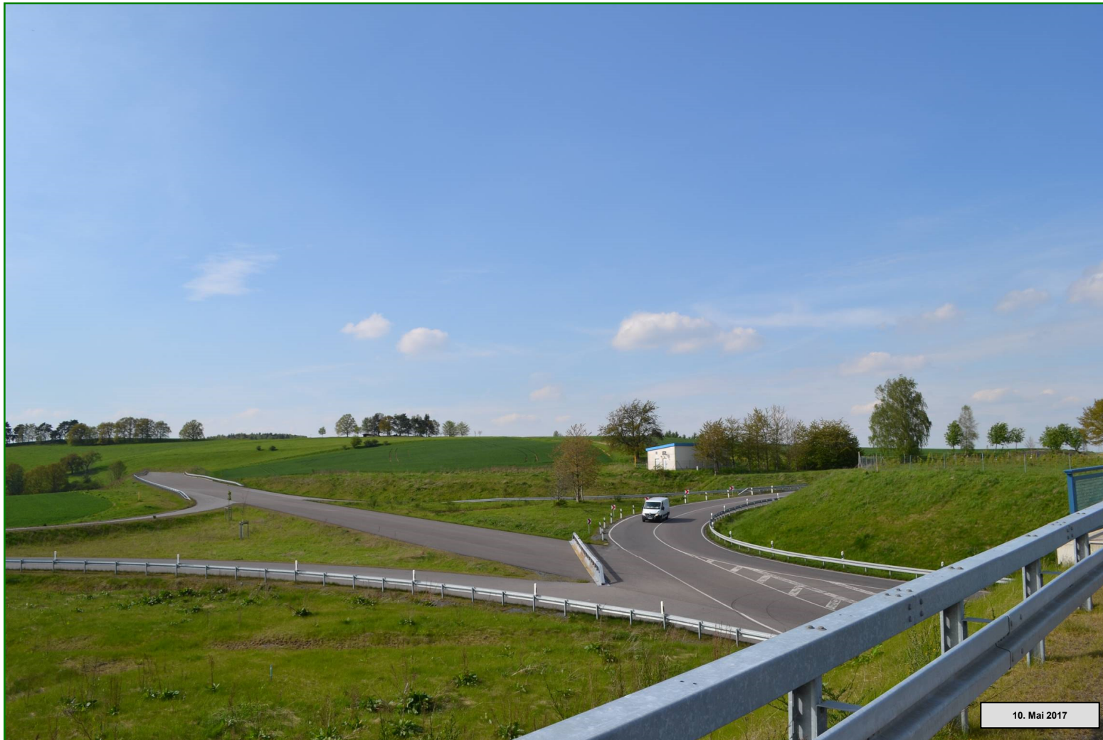
Staatsstraße S 177 - Ortsumgehung Wünschendorf / Eschdorf Bauanfang südlich des Doberberges an der Kreuzung mit der S 177 alt
