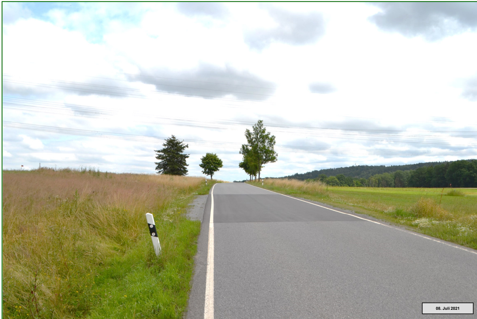
Staatsstraße S 177 - Ortsumgehung Wünschendorf / Eschdorf Staatsstraße S 161 mit Blick in Richtung Dittersbach
