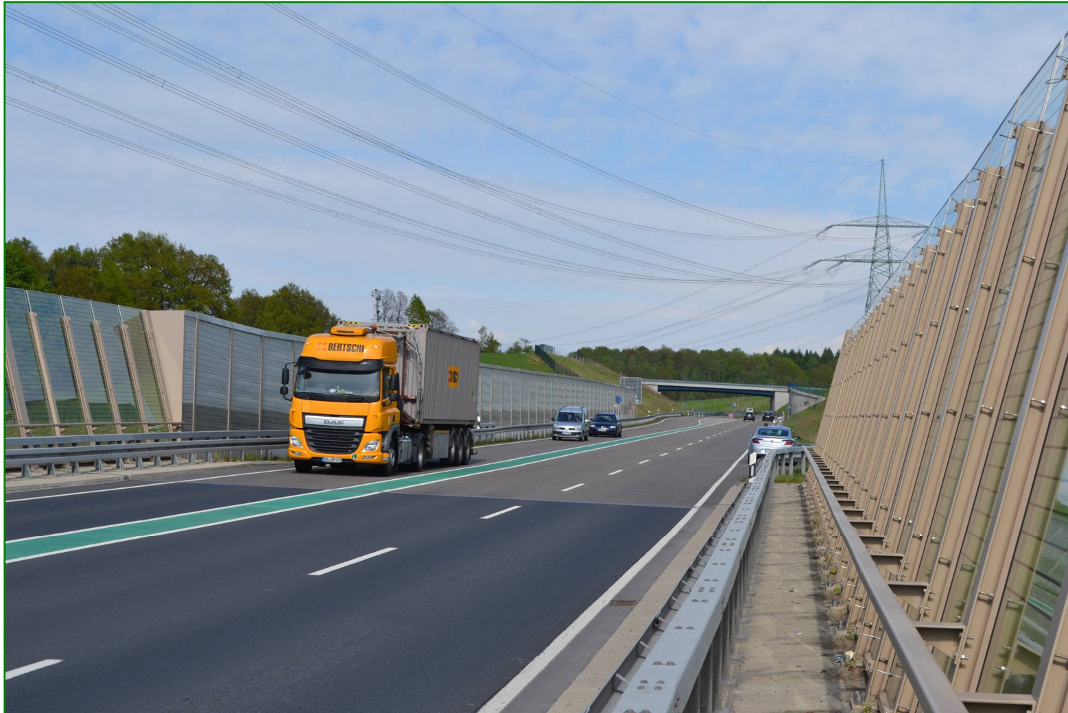
Staatsstraße S 177 - Ausbau nördlich Pirna mit Ortsumgehung Bonnewitz Brückenbauwerk über den Bonnewitzer Grund
