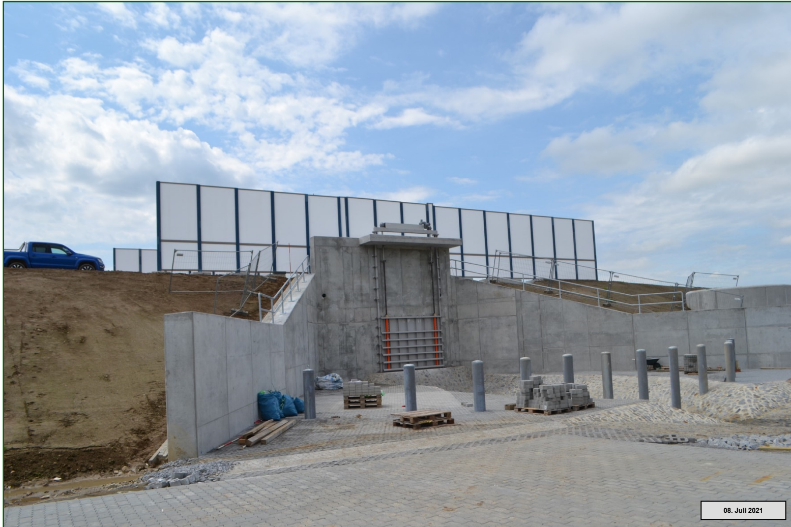
Staatsstraße S 177 - Radeberg bis Bundesautobahn A 4 Hochwasserschutzbauwerk der Kleinen Röder nördlich der Autobahn
