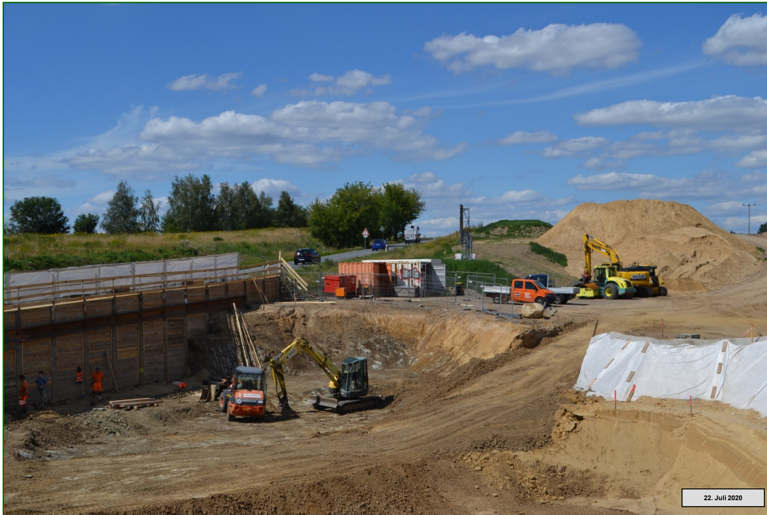
Staatsstraße S 177 - Ortsumgehung Wünschendorf / Eschdorf Baugrubenaushub - Brückenbauwerk 11 über die alte Staatsstraße
