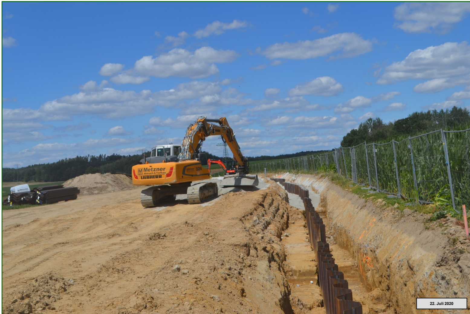
Staatsstraße S 177 - Ortsumgehung Wünschendorf / Eschdorf Einbau der Dichtwand östlich des Rosinendörfchens
