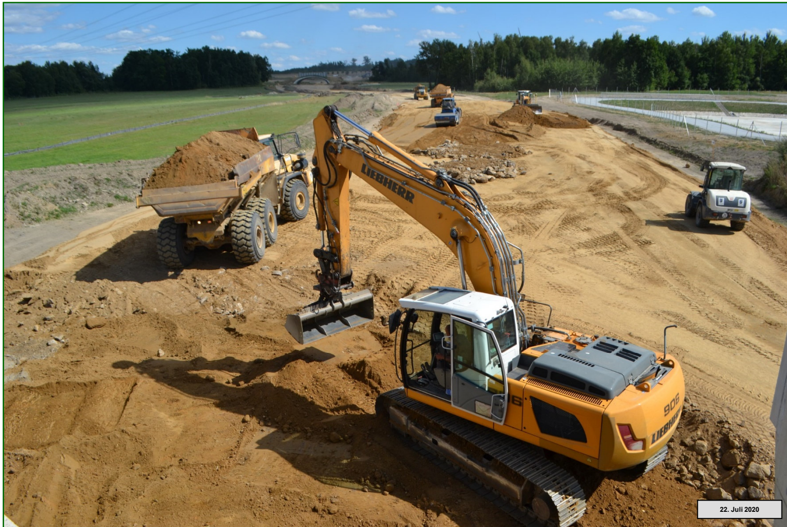
Staatsstraße S 177 - Radeberg bis Bundesautobahn A 4 Erdbau im Straßenbaulos 5.1 westlich von Leppersdorf
