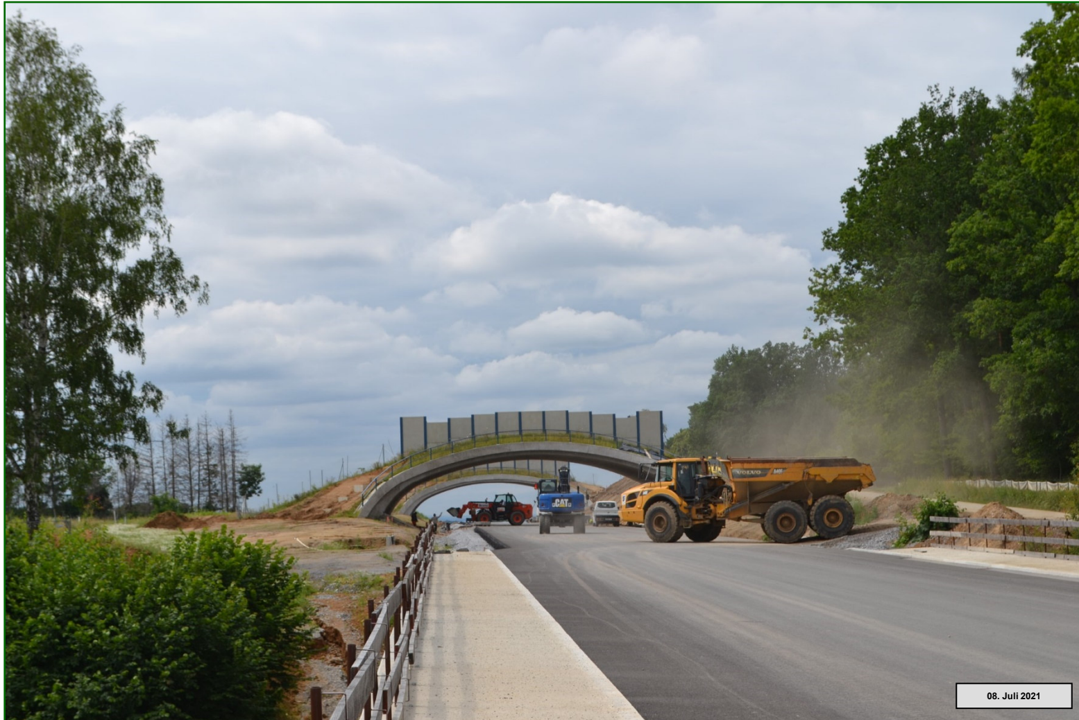
Staatsstraße S 177 - Radeberg bis Bundesautobahn A 4 Bauarbeiten im Straßenbaulos 5.1 südlich von Leppersdorf
