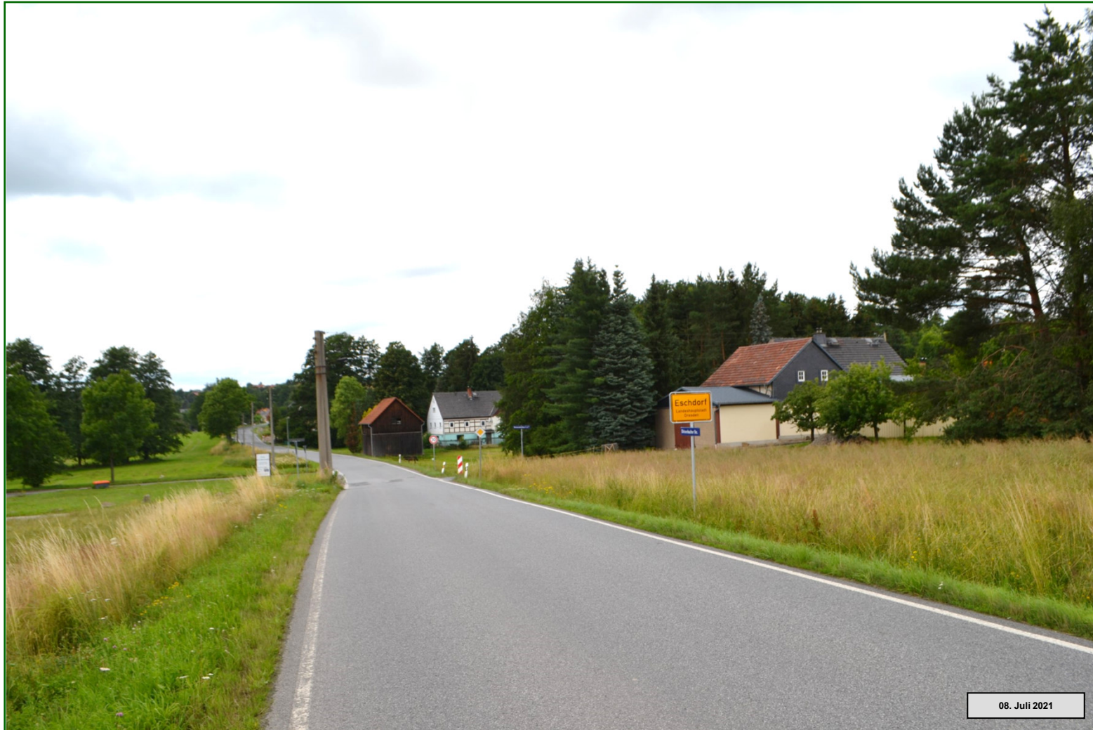
Staatsstraße S 177 - Ortsumgehung Wünschendorf / Eschdorf Staatsstraße S 161 mit Blick in Richtung Eschdorf
